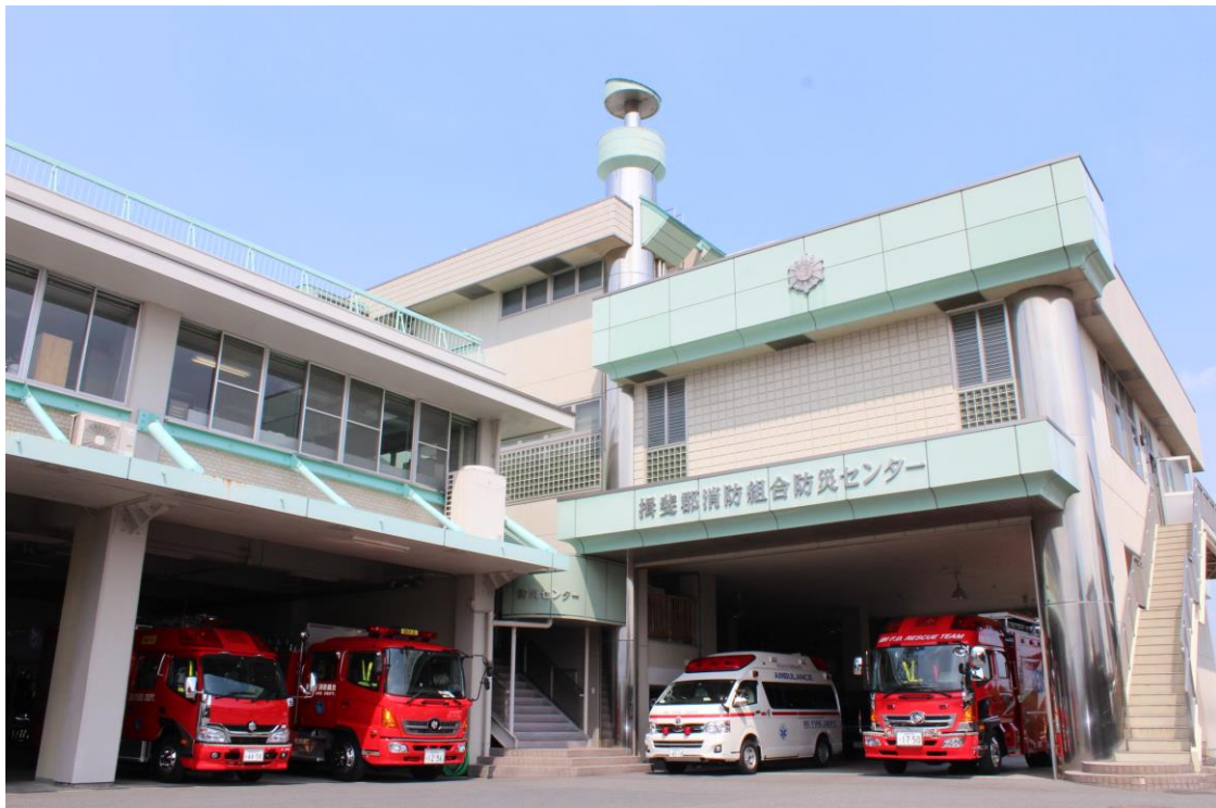
揖斐郡消防組合消防本部・署・防災センター庁舎
